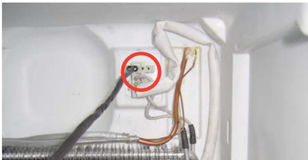
N.B.: La sonde à air du congélateur est accrochée dans son siège. Pour l'enlever et la remettre en place, il suffit d'exercer un pression.
